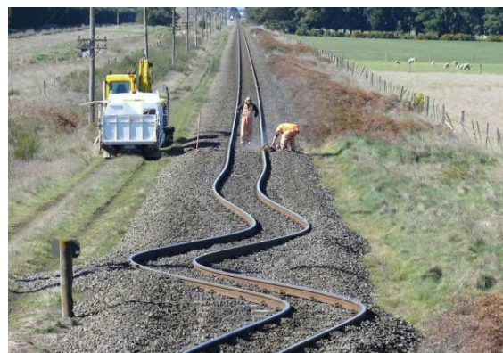
▲ При «выбросе» геометрия рельса резко меняется за доли секунды
